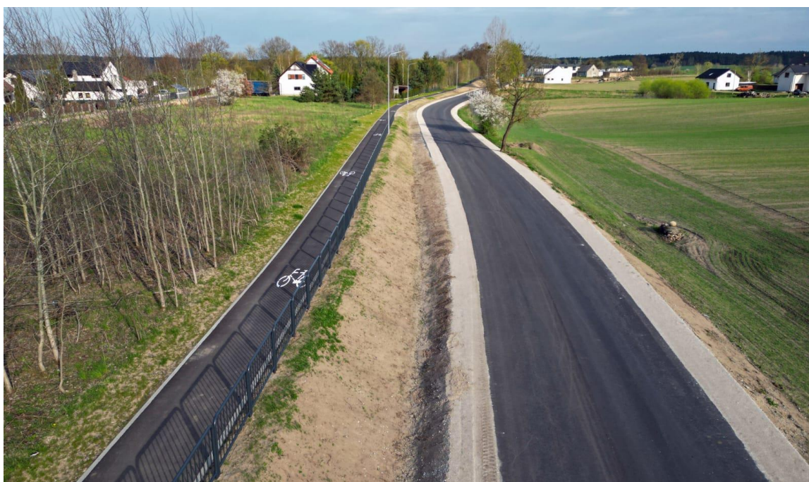
Zdjęcie 3. Przebudowa publicznej drogi gminnej nr 213041G Owidz-Barchnowy.
