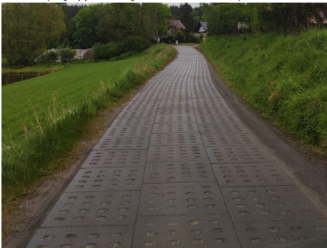
Zdjęcie 2. Modernizacja drogi w Starym lesie wykonana z płyt IOMB.
