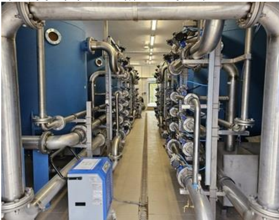
Zdjęcie 1. Rozbudowa stacji uzdatniania wody w Jabłowie.
