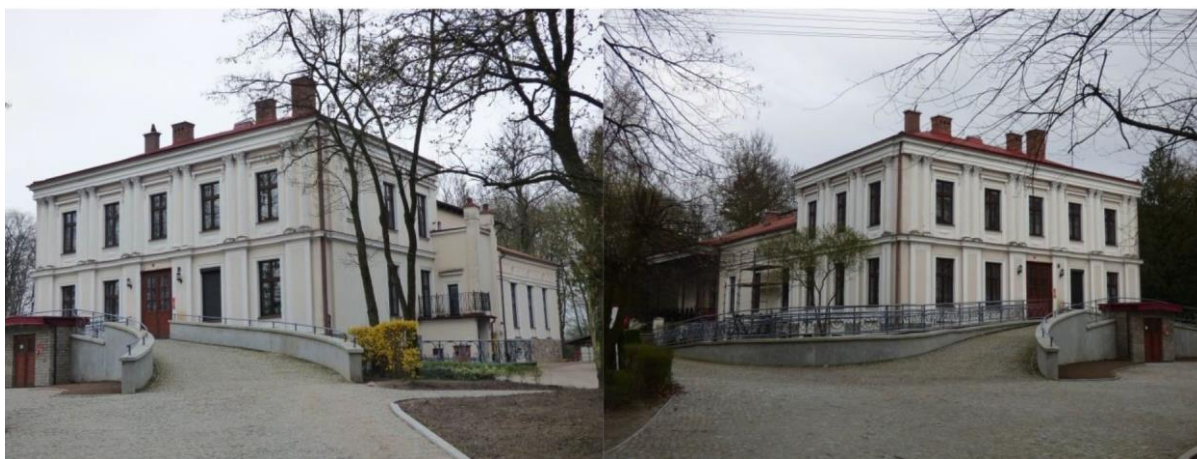
Fot. 9. Rokocin. Dwór (źródło - Gminna Ewidencja Zabytków).
