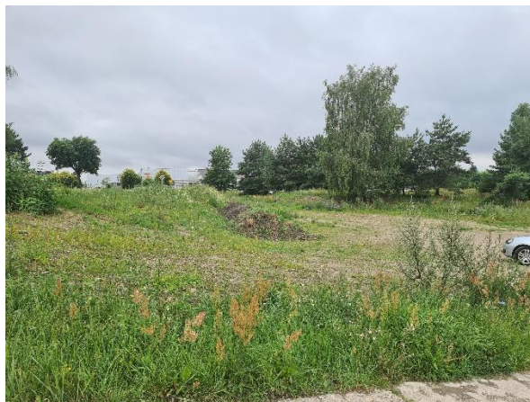
obniżenie terenu w rejonie skrzyżowania Boczna-Nowowiejska
