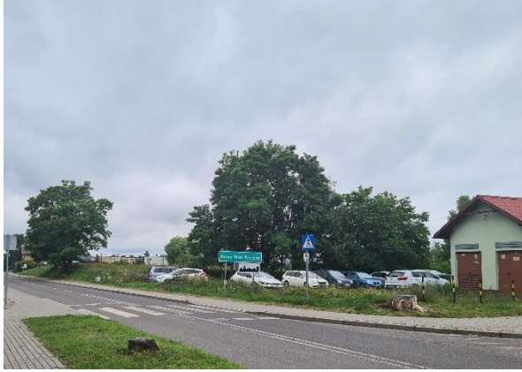
Parking i stacja transformatorowa
