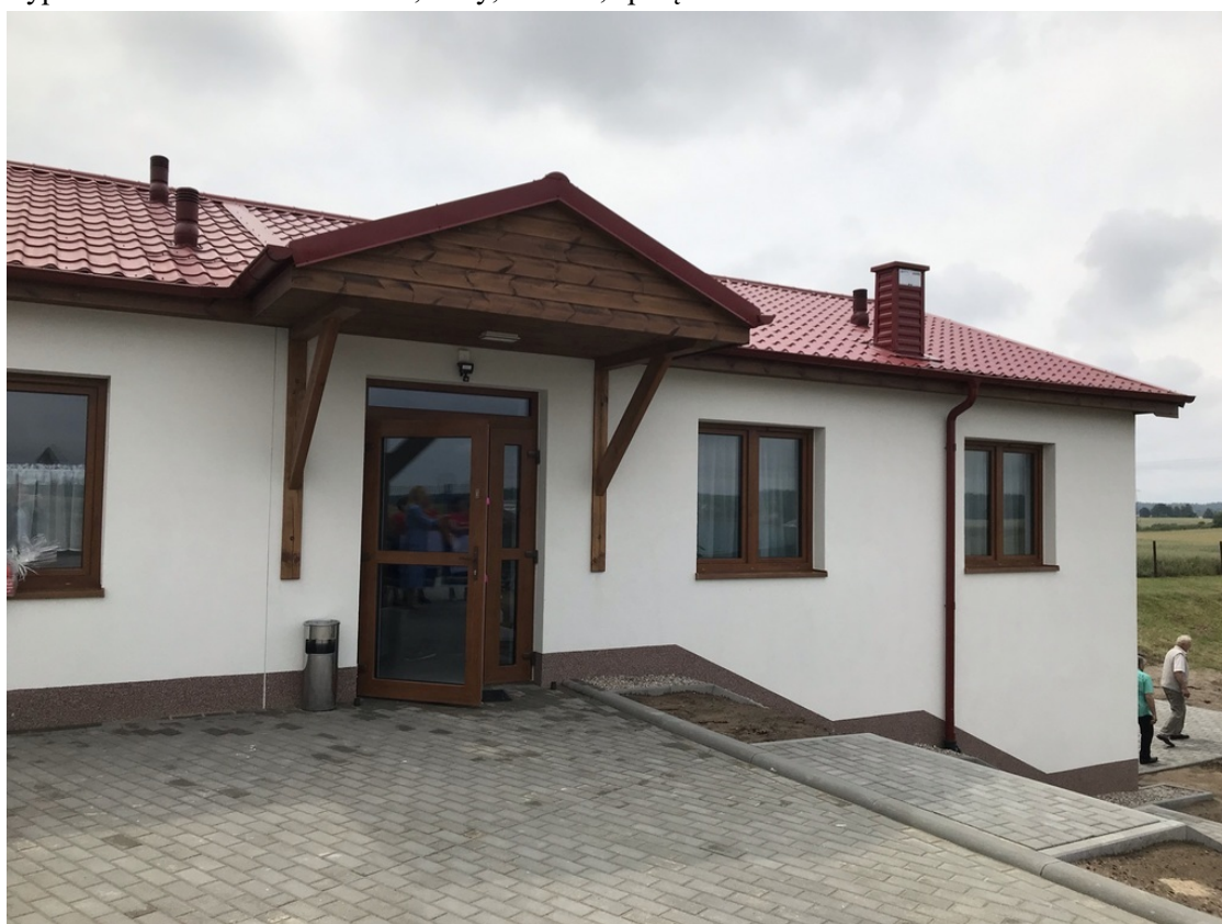
Zdjęcie 2. Rozbudowany budynek zaplecza boiska sportowego w Zdunach
