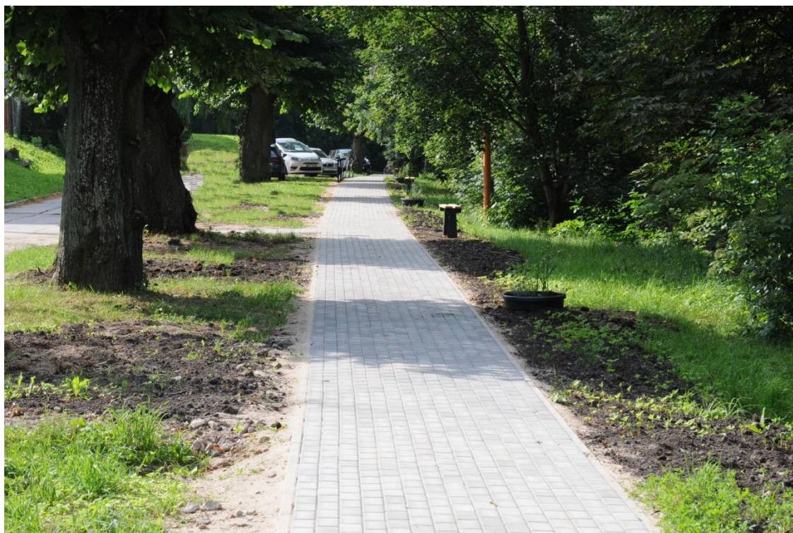
Zdjęcie 1. Chodnik z kostki brukowej przy ul. Nad Jeziorem w Jabłowie
